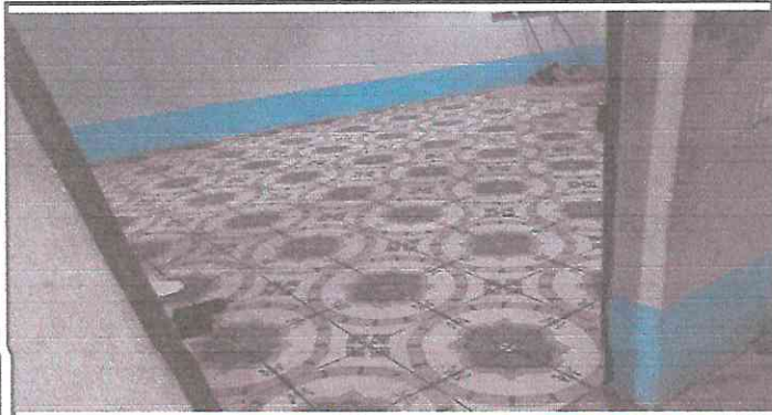
Foto 1: Reparacion de piso
