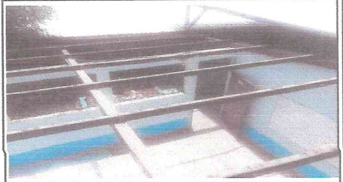
Foto 2: Reparacion de techo (Lamina)
